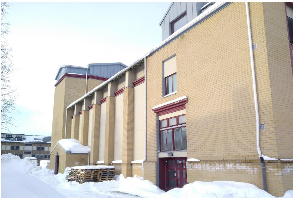
Figur 1 Bygningen side mot sydvest, med kontor- og leilighetsfløy i forgrunnen og scenetårnet lengst vekk.
