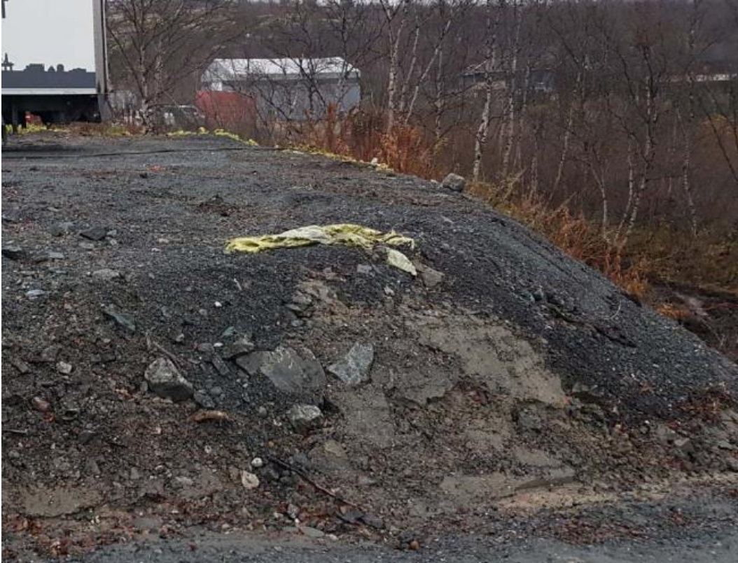
Foto av utfylling mot elvedal
