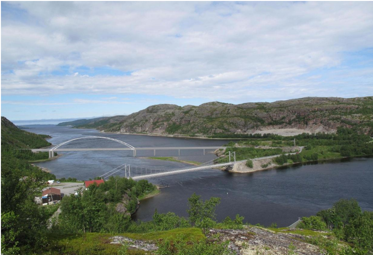
Figur 12 - Nettverksbuebru og viadukt. Bildet er tatt ved høyvann. Fotomontasje: Statens vegvesen
