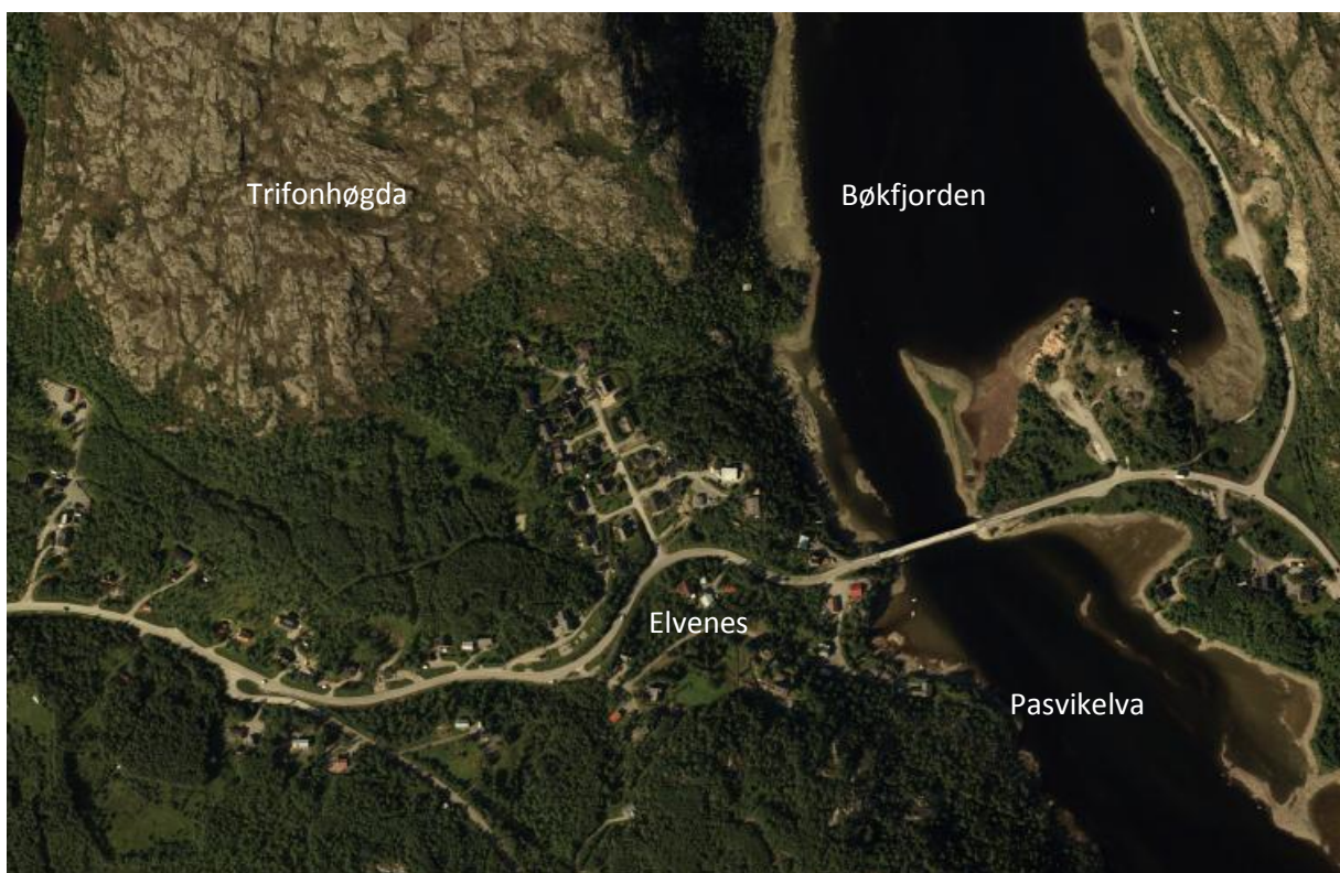
Figur 6: Bygda Elvenes med bru over Pasvikelva. Fv. 354 fortsetter mot nord. Flyfoto: Norge i bilder.
