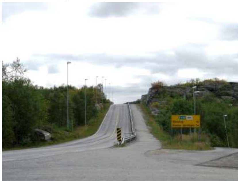
Figur 5 - Høybrekk over Ekhaugen skal flates ut
