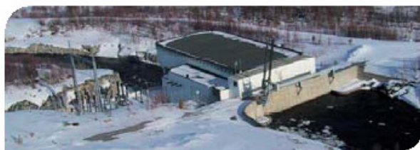
Melkefoss Kraftverk Elvekraftverk Årsmiddelproduksjon: 129 GWh Installert effekt: 1 x 26 MVA Ikke noe praktisk magasin
