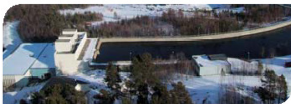
Skogfoss Kraftverk Elvekraftverk Årsmiddelproduksjon: 258 GWh Installert effekt: 2 x 30 MVA Inntaksmagasin 50 km 2 , utgjør kun inntil 900 MWh/ uke i regulering
