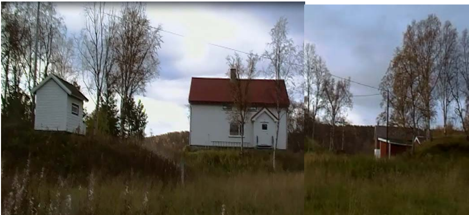
Hovedhuset og tilliggende dokkestue, garasje og uthus, sett fra nord
