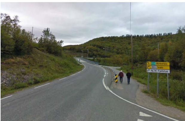
Gangforbindelse fra rasteplass over Neiden bru.
