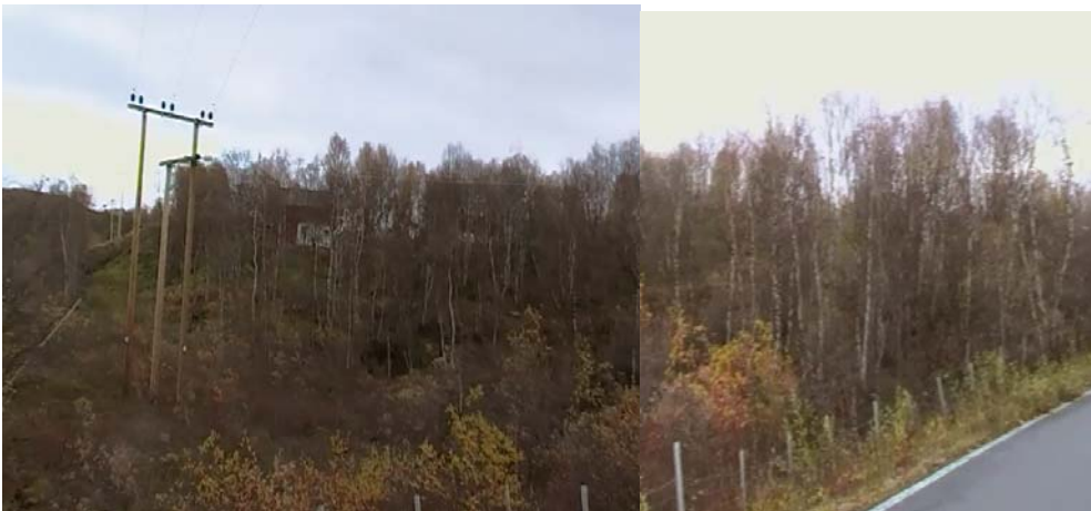
Tett løvtrevegetasjon i skrånende terreng opp mot bebyggelsen og langs avkjøring til rasteplassen.
