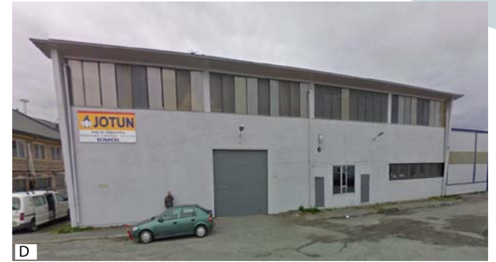
Figur 196: Bygges om til godslager for Hurtigruten og utvides noe (Google Street View)
