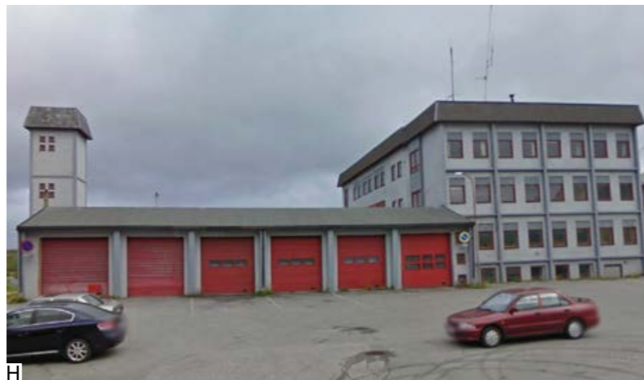
Figur 206: Bygningen og garasjene rives. Branntårnet beholdes i videre utforming (Google Street View)
