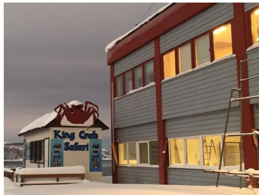
Fig 30: Fasade langs E6 i sentrum
