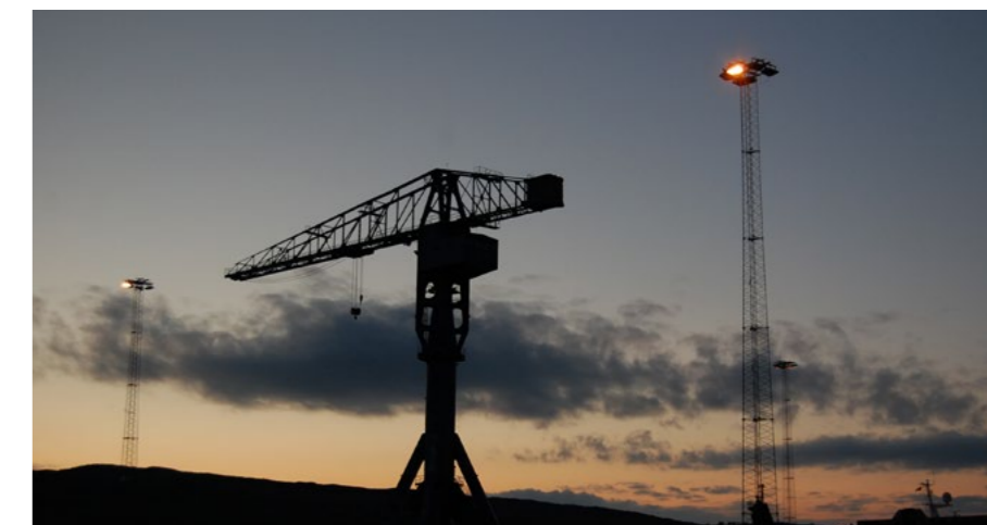
Fig 16: Kranen ved Kimek
